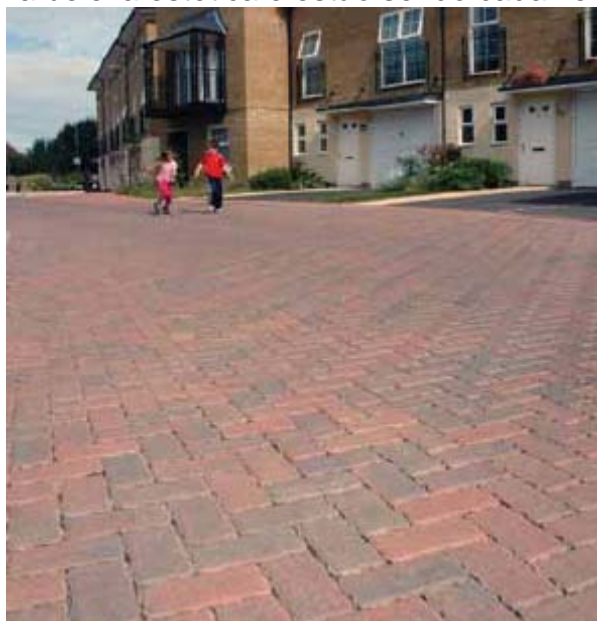
Figura 1- pavimento permeável intertravado
