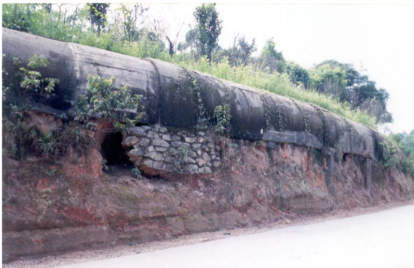
Foto Massami em 2003- Aqueduto do Cabuçu feito em concreto com cimento vindo da Inglaterra.
