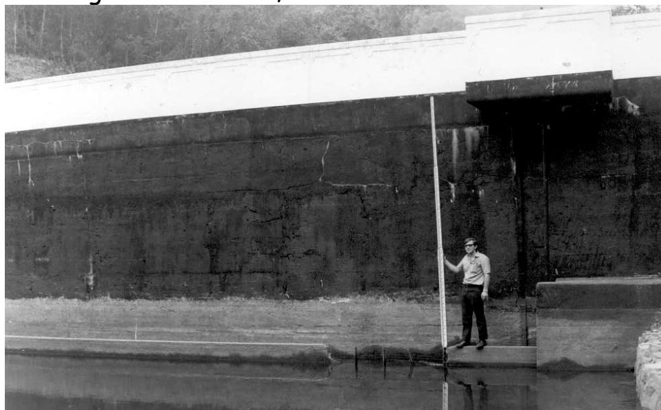
Foto do costado da barragem arco gravidade do Cabuçu tirada pelo engenheiro Plínio Tomaz durante a seca de 1969.
