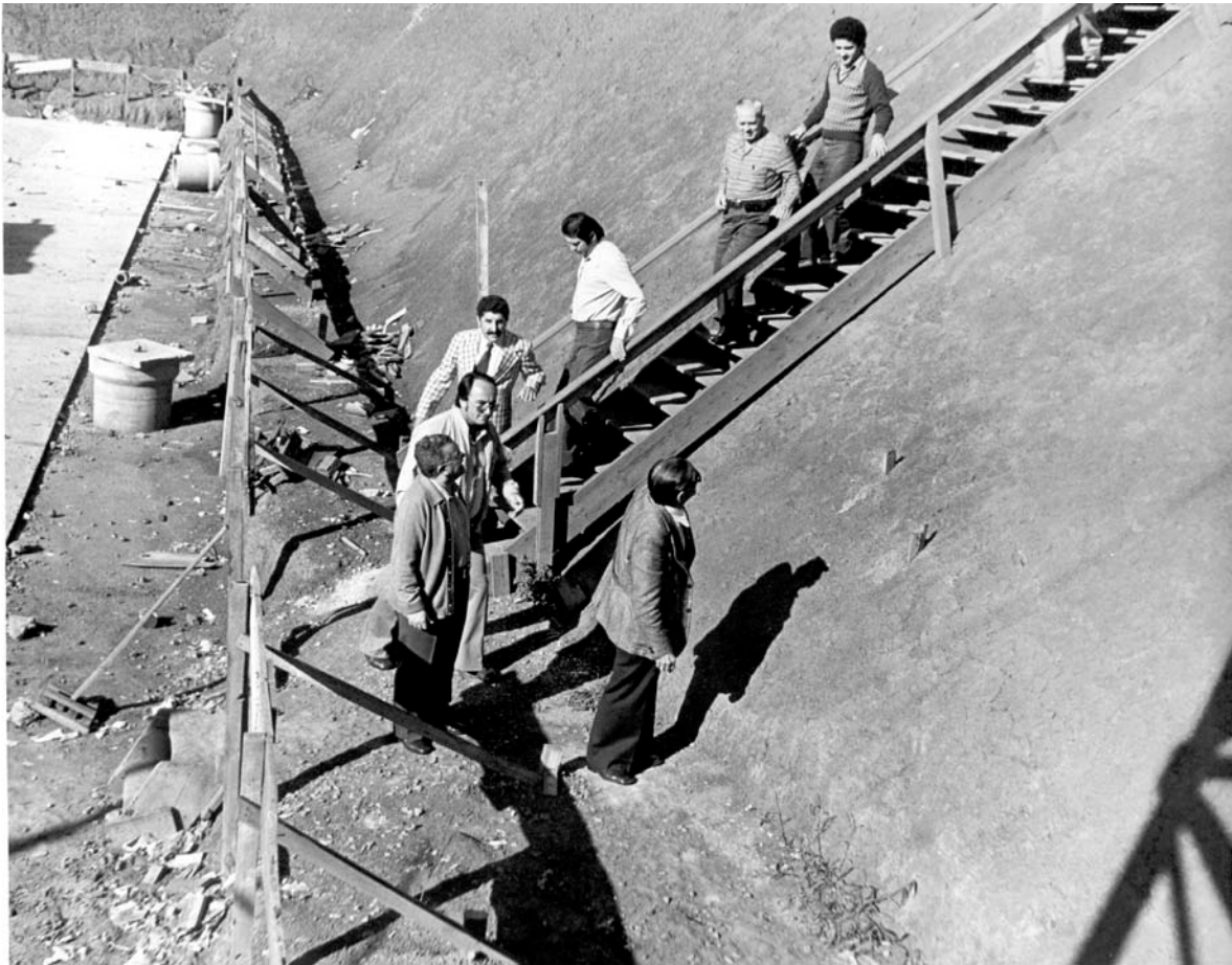
Foto do final da rampa ao nível do fundo do reservatório: Waldormiro Pompeo, Heitor Mauricio de Oliveira, Plínio Tomaz, Abdul Assis Miguel.
