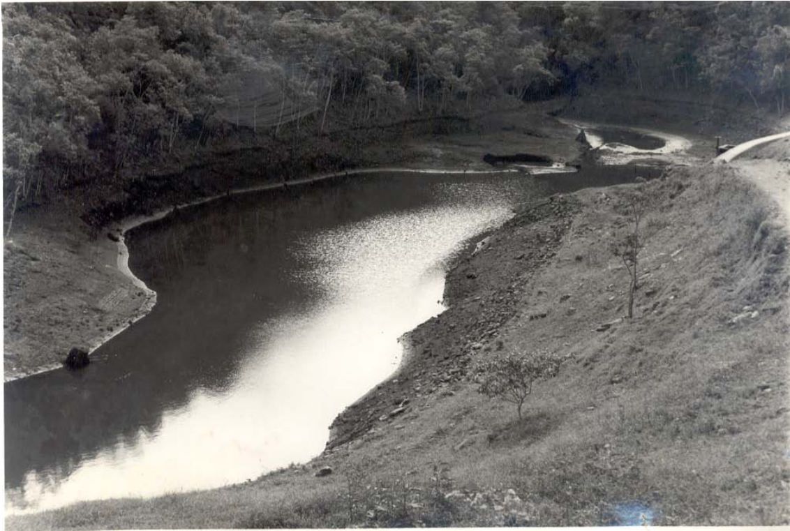
Foto Tanque Grande com água após a destruição da barragem do Japonês que estava à montante. Ano de 1969.
