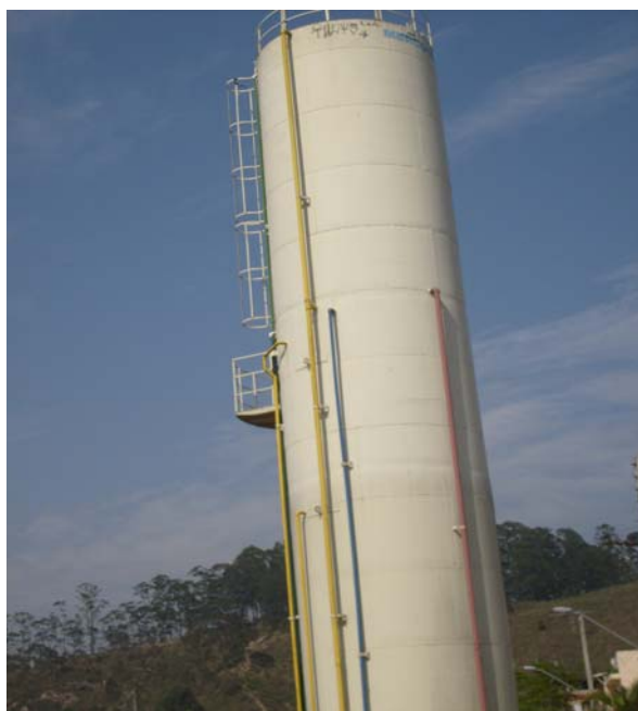
Figura 2.5 Reservatório elevado de estrutura metálica da CMEI Érico Veríssimo (Jardim Fortaleza), Guarulhos – SP
