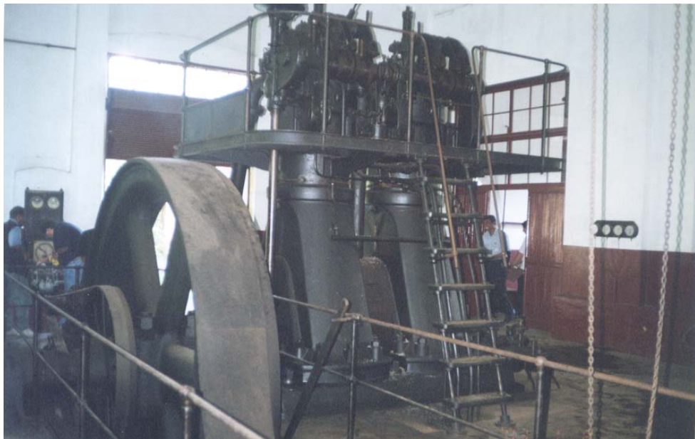
Foto tirada pelo engenheiro Plínio Tomaz em 2002. As bombas centrífugas eram acionadas por motor Diesel sendo a transmissão por correias de couro.
