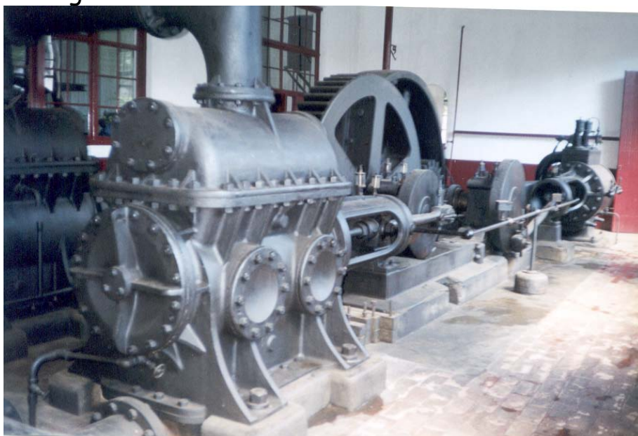
Foto tirada pelo engenheiro Plínio Tomaz em 2002. Bomba de pistão de ferro fundido.
