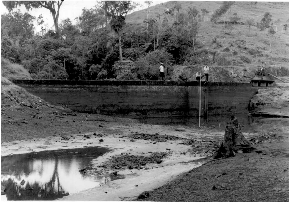
Foto tirada pelo engenheiro Plínio Tomaz da barragem arco gravidade em concreto do Tanque Grande durante a seca de maio de 1969.
