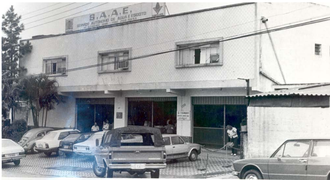
Foto da sede do SAAE da av. Guarulhos
