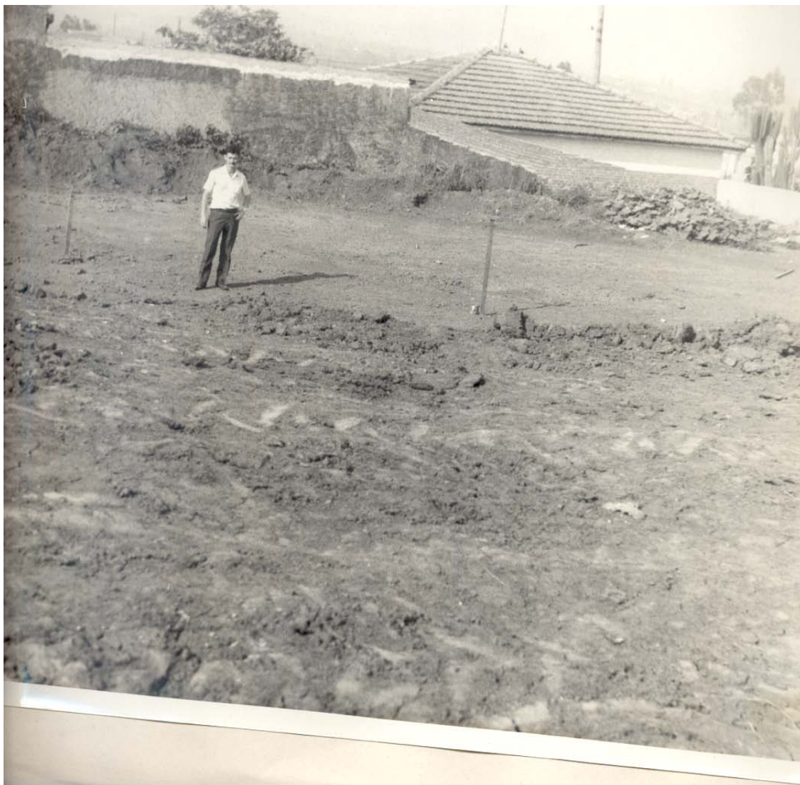
Foto da base do reservatório do Picanço, vendo-se o engenheiro Edmur Borges Franco de Uberaba que trabalhava no SAAE.
