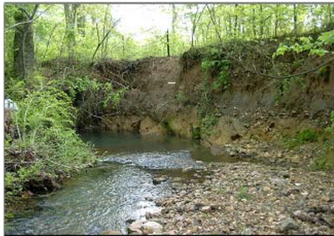
Figura 41.5 - Exemplo de erosão de um curso de água
