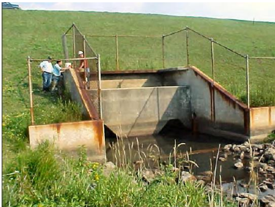
Figura 6- Inspeção periódica no dissipador Tipo VI. Fonte: Fema, 2010
