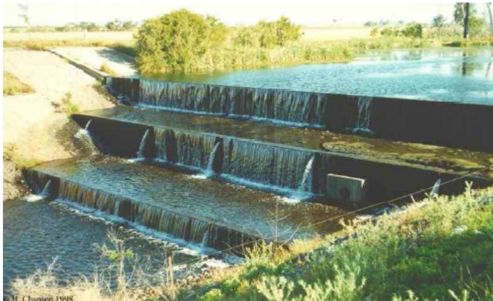
Figura 58.3- Escoamento nappe flow (com quedas sucessivas)
