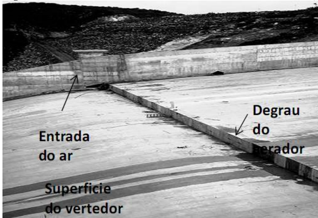
Figura 91.11- Geometria de um aerador de fundo. Fonte: Brito, 2011
