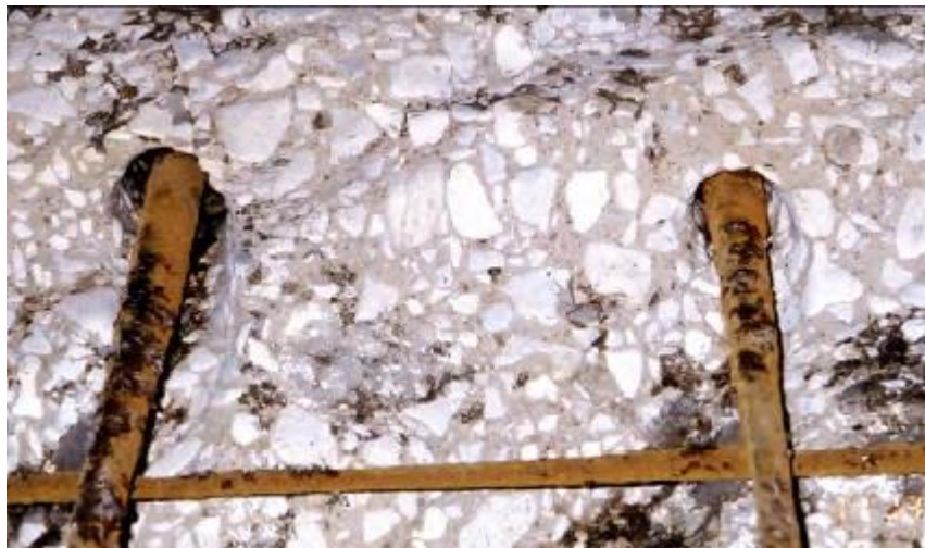
Figura 5-Efeito da vibração no concreto. Fonte: fema, 2010
