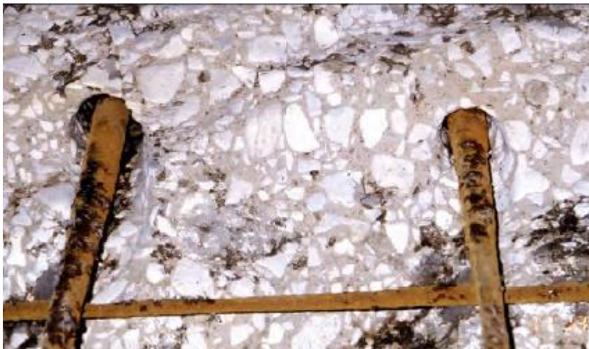
Figura 5-Efeito da vibração no concreto. Fonte: fema, 2010
