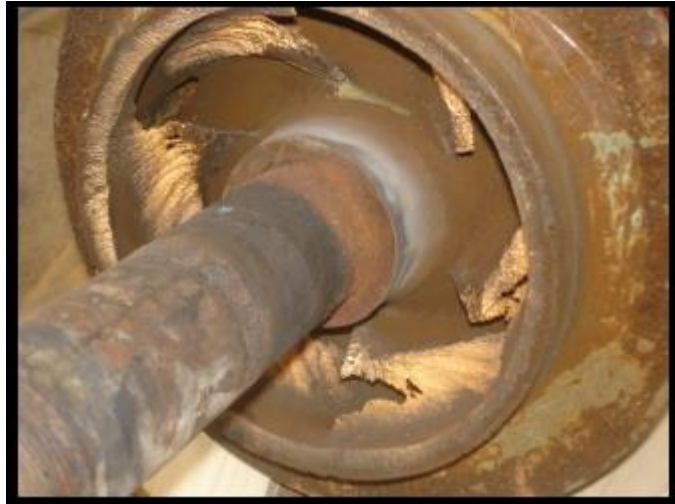
Figura 1.2 Cavitação em bomba no ano 2007
