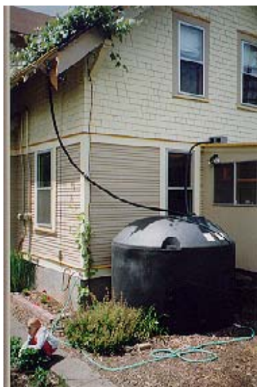
Figura 13- Aproveitamento de água de chuva com reservatórios de plástico.
