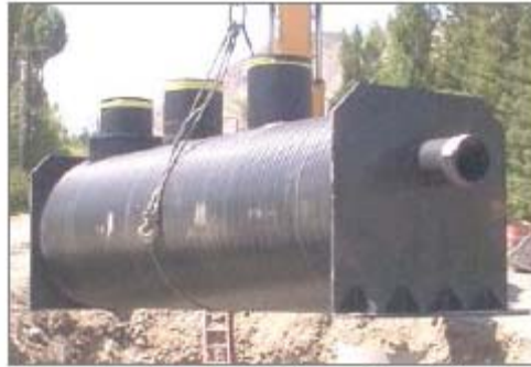
Figura 25.12-Sistema de filtração pré-fabricado da Aqua-Filter fornecido pela firma Aquashield
