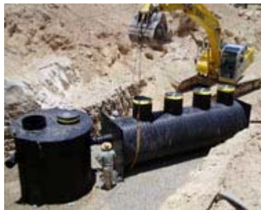
Figura 25.10-Montagem de um sistema Aquafilter fornecido pela firma Aquashield http://www.aquashieldinc.com/stormwater/aqua-filter.html
