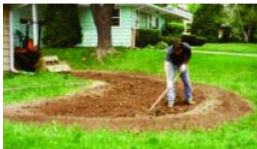
Figura 32.6- Construção de um pequeno rain garden que infiltrará a água vinda do telhado. Observar a berma de terra. Após enchimento a água passará por cima da berma.
