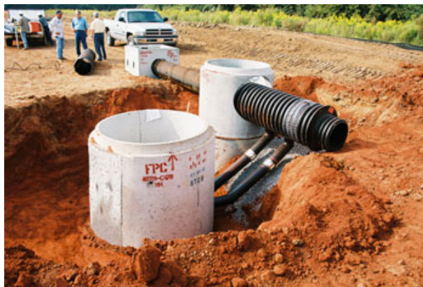
Figura 36.21- Instalação de Baysaver .
