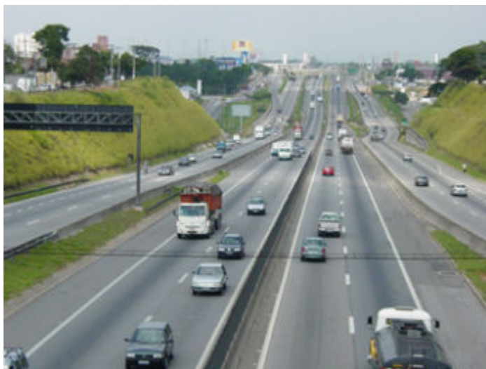
Figura 36.4- Estradas de rodagem asfaltadas
