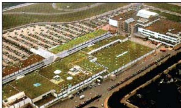
Figura 51.3- Cobertura verde na indústria Ford com vegetação extensiva. Fonte: http://crd.dnr.state.ga.us/assets/documents/GGG3C.pdf
