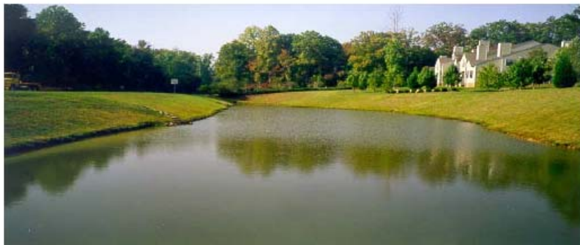
Figura 52.3 -Exemplo de lagoa de retenção.
