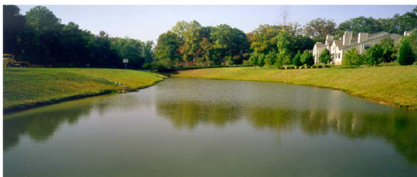
Figura 52.1- Vista de um reservatório de retenção (wet pond)
