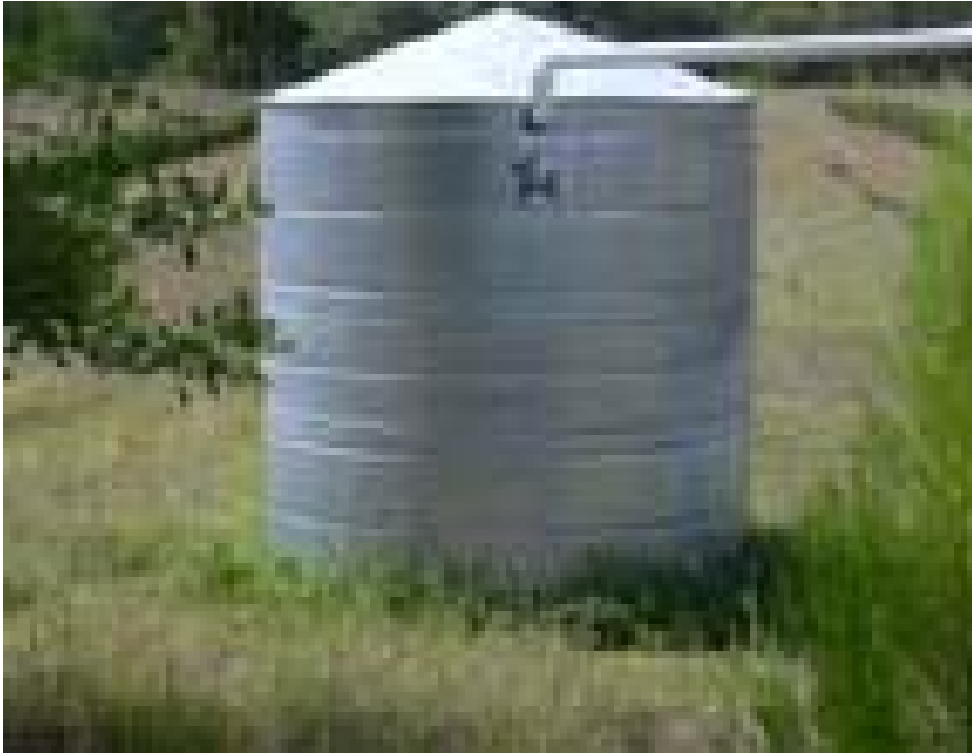
Figura 53.8- Reservatório de chapa de aço
