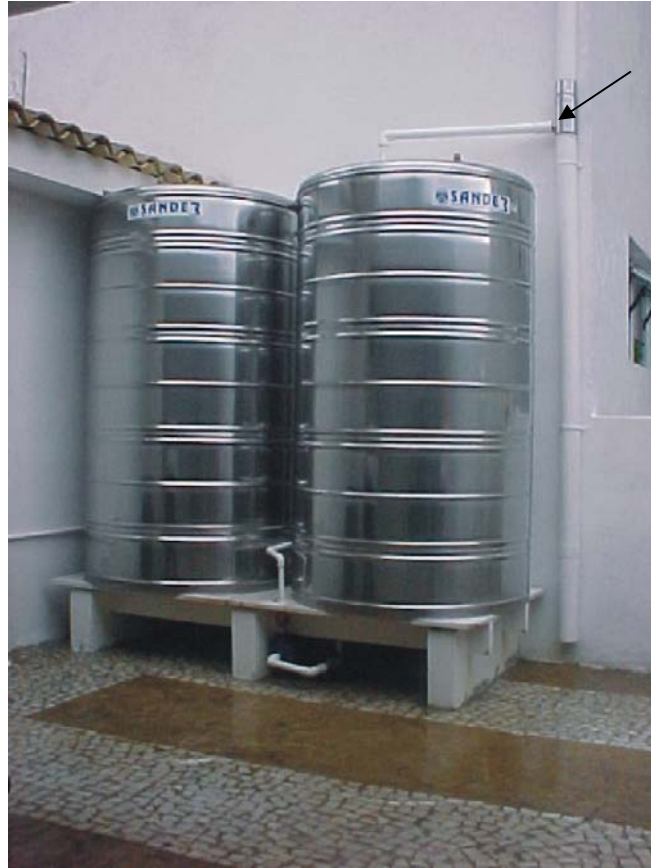
Figura 53.4 - Dois reservatórios de aço inox com 2.000 litros cada. Observar o filtro (seta).
