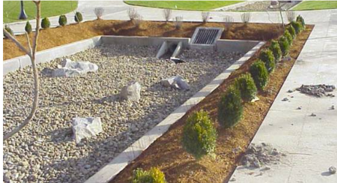
Figura 57.4 - Filtro de areia de superfície.
