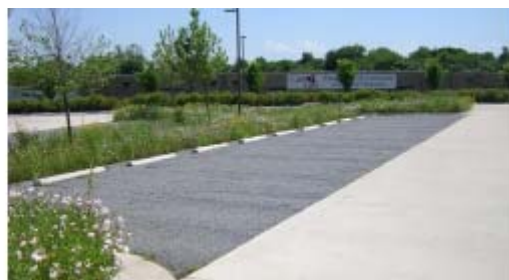
Figura 60.6- Pavimento poroso com grama reforçada que permite que a água passe pela zona das raízes e vá até o solo ficando uma superfície resistente inclusive para passagem de veículos. Fonte: http://www.flowstobay.org/
