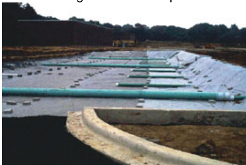
Figura 60.11 - Esquema de um asfalto poroso, mostrando os tubos de drenagem.
