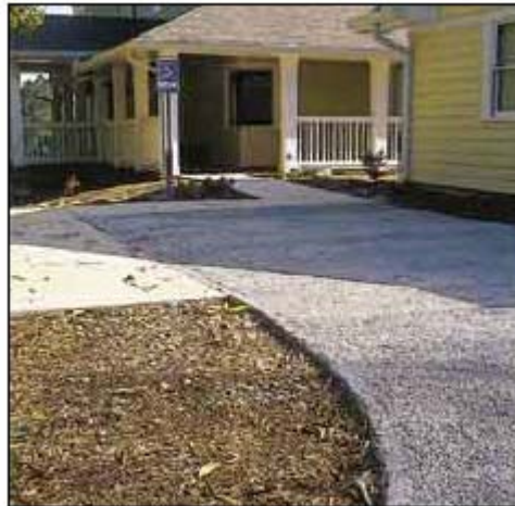
Figura 60.13 - Pavimento permeável de concreto
