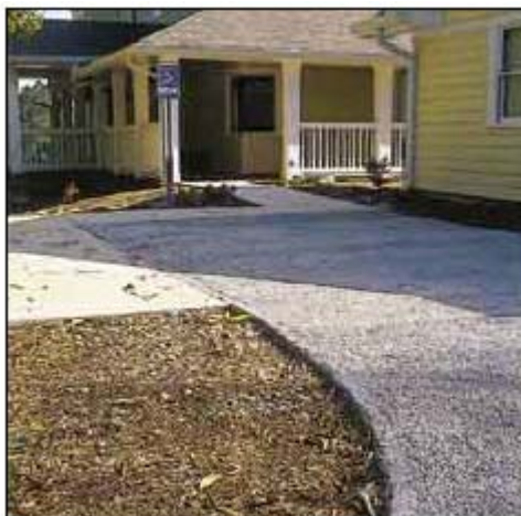
Figura 60.13 - Pavimento permeável de concreto
