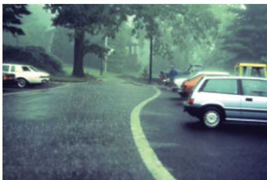
Figura 60.3 – Mostra, a esquerda, o asfalto tradicional que leva o runoff para a direita, onde está o asfalto poroso.
