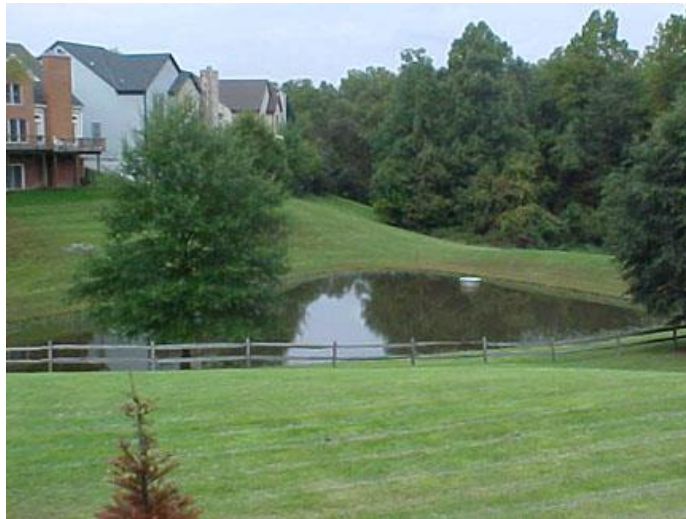
Reservatório de retenção (wet pond)
