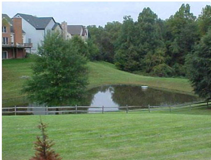
Reservatório de retenção (wet pond)
