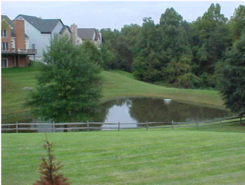
Figura 40.2 - Lagoa de retenção alagada pode ser considerado um sistema aberto para o balanço hídrico.
