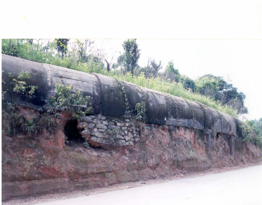
Aqueduto do Cabuçu em Guarulhos. Foto tirado pelo Massami Kishi
