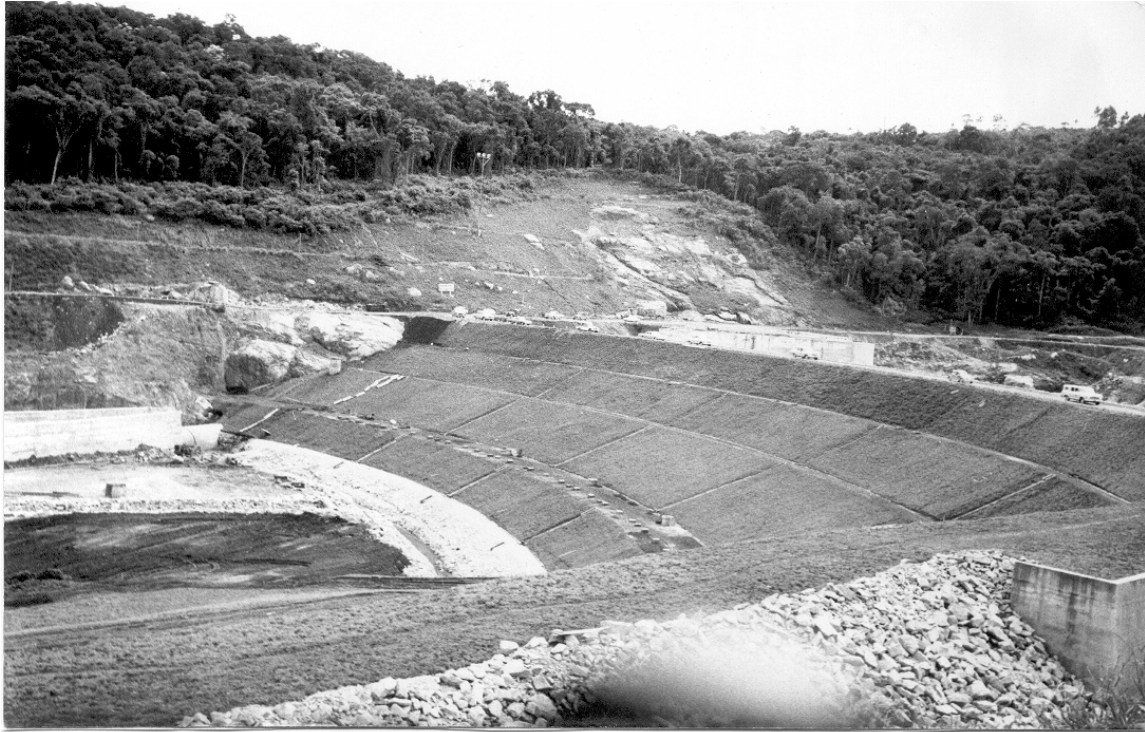
Foto tirada pelo engenheiro Plínio Tomaz da Barragem Paiva Castro durante visita.
