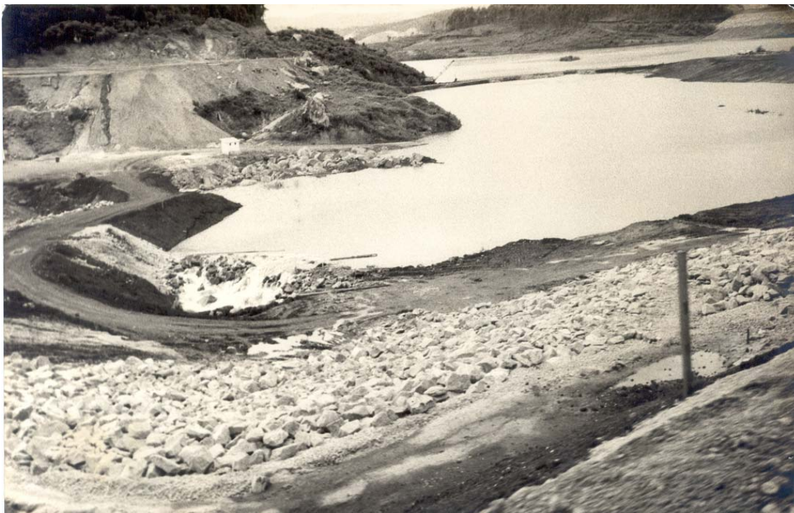
Foto da barragem Paiva Castro durante a construção.
