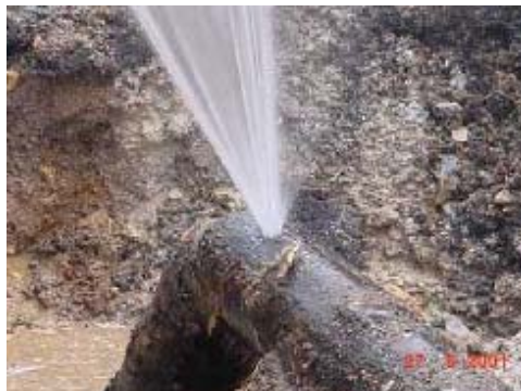
Figura 4.20- Vazamentos
