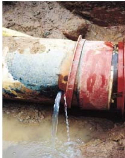
Figura 4.18- Vazamentos
