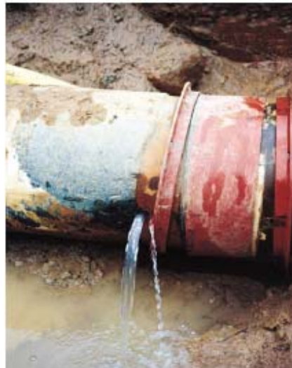
Figura 4.18- Vazamentos
