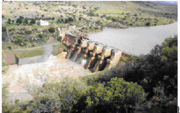
Figura 1.11- Barragem com aeração da água
