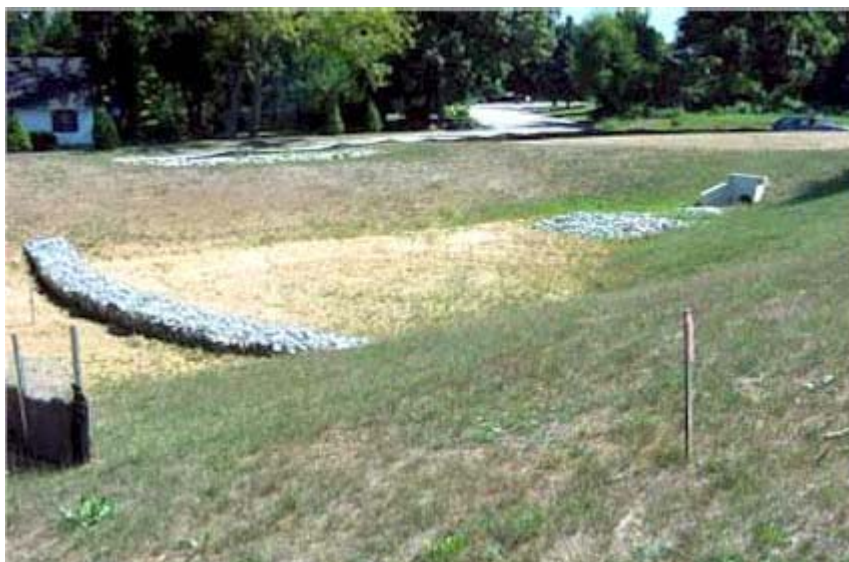
Figura 11.1- Unidade fixa de pré-tratamento. Observar rip-rap na saída da tubulação e que temos um barramento feito de pedras britadas e que há espaço lateral para manutenção
