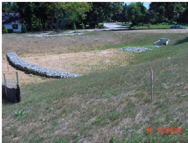
Figura 12.1-Pré-tratamento. Uma parte dos 0,1WQv da água pluvial fica armazenada e outra passa por cima do vertedor em gabião.
