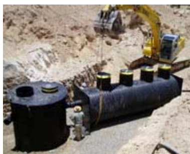
Figura 12.10-Montagem de um sistema Aquafilter fornecido pela firma Aquashield http://www.aquashieldinc.com/stormwater/aqua-filter.html
