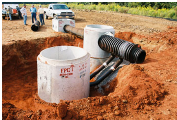
Figura 14.21- Instalação de Baysaver .
