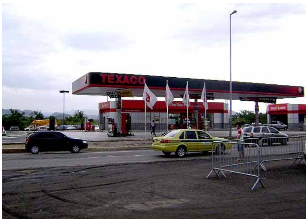
Figura 14.1- Posto de gasolina
