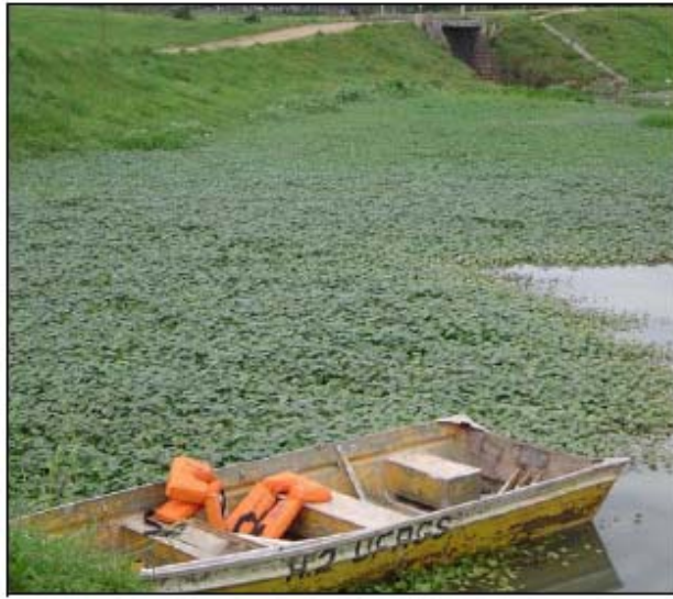
Figura 15.5-Reservatório de retenção- Aguapés Fonte: Neves et al, 2005
