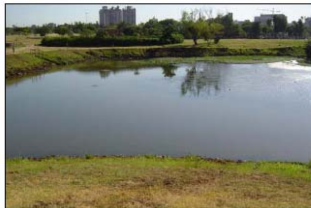
Figura 15.2-Reservatório de retenção Fonte: Neves et al, 2005
