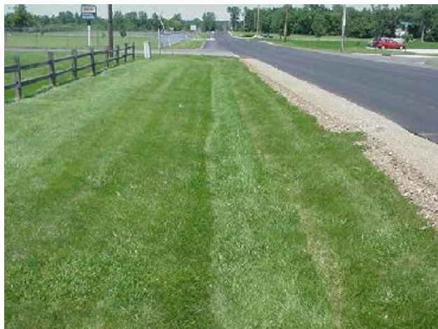
Figura 21.1- Canal gramado usual a beira de uma estrada em local de baixa densidade habitacional
